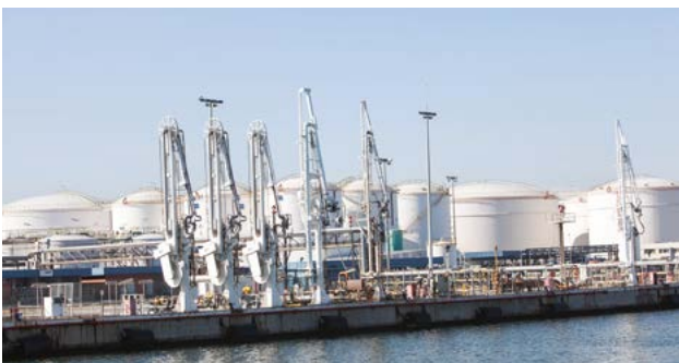
Terminal para el transporte marítimo de BASF en Tarragona
